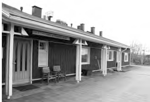
写真2 キルピスヤルヴィのフィールド・ステーション
